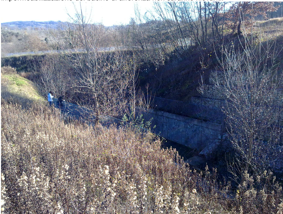
Canalizzazione del Fosso di Pian dell'Abate in corrispondenza degli ambiti di programmazione
